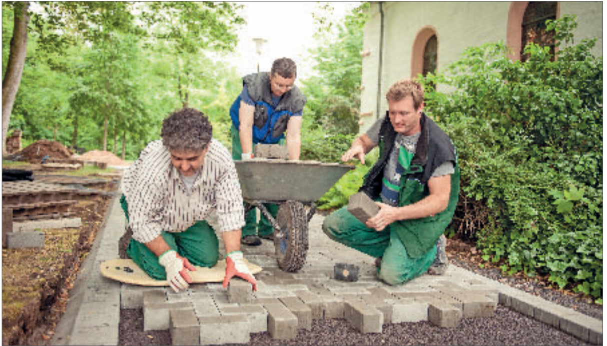
Maurermeister Sebastian Dorsch (ganz re.) beim Anleiten von Verlegearbeiten auf dem Friedhof Leiselheim.
