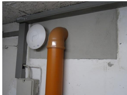
Waschkeller statt Fenster
