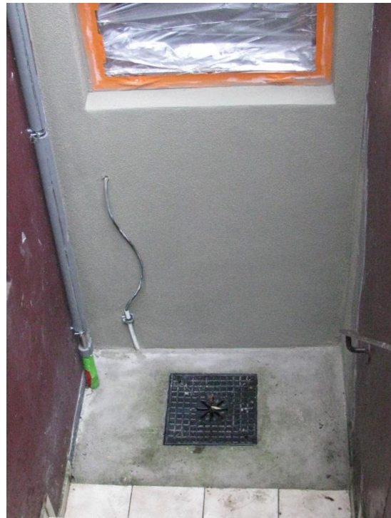
Zugemauerte Kellertür mit Bodenablauf
