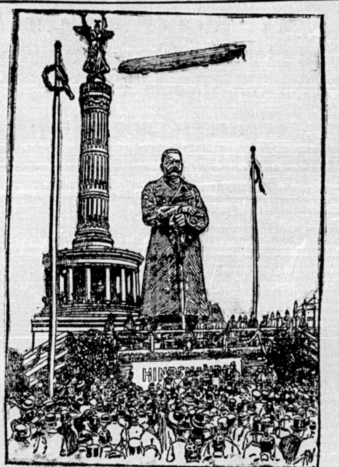
Die Aufstellung der Eisen-Hindenburg
