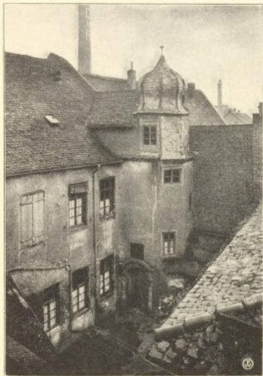
Domstiftliches Haus Speycerstraße 32 (Blick in den Hof mit Treppenturm)
