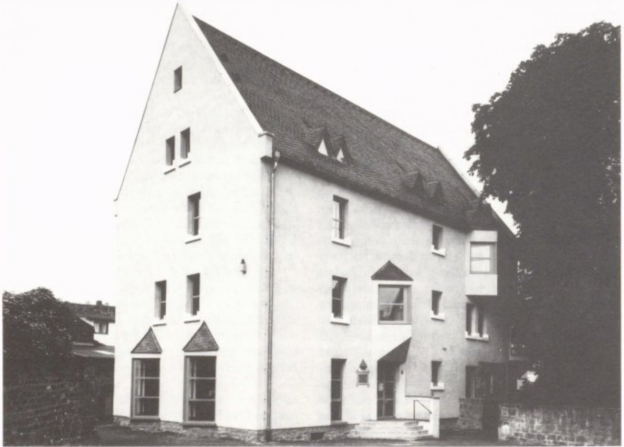
Raschi-Haus neben der Alten Synagoge, in Dienst gestellt am 29. November 1982
