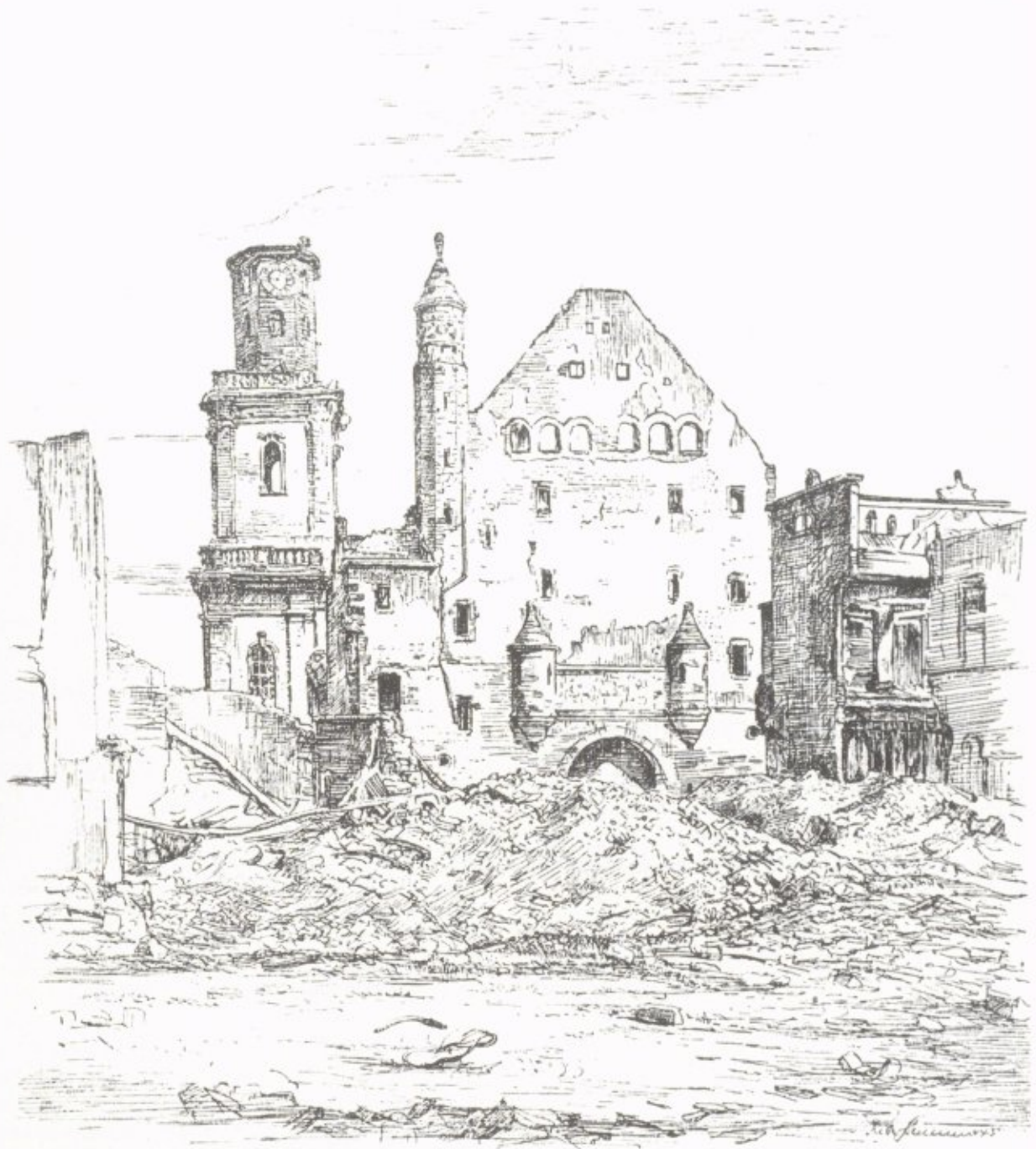
Blick aus Richtung Scharrengasse (heute Südteil des Parkplatzes am Neumarkt) auf den Turm der Dreifaltigkeitskirche, das „Cornelianum“ und die Gaststätte „Zwölf Apostel“ an der Hagenstraße, gezeichnet Sommer 1945 von Richard Stumm, gedruckt Januar 1946 als Beilage zum Wiederaufbauplan.
