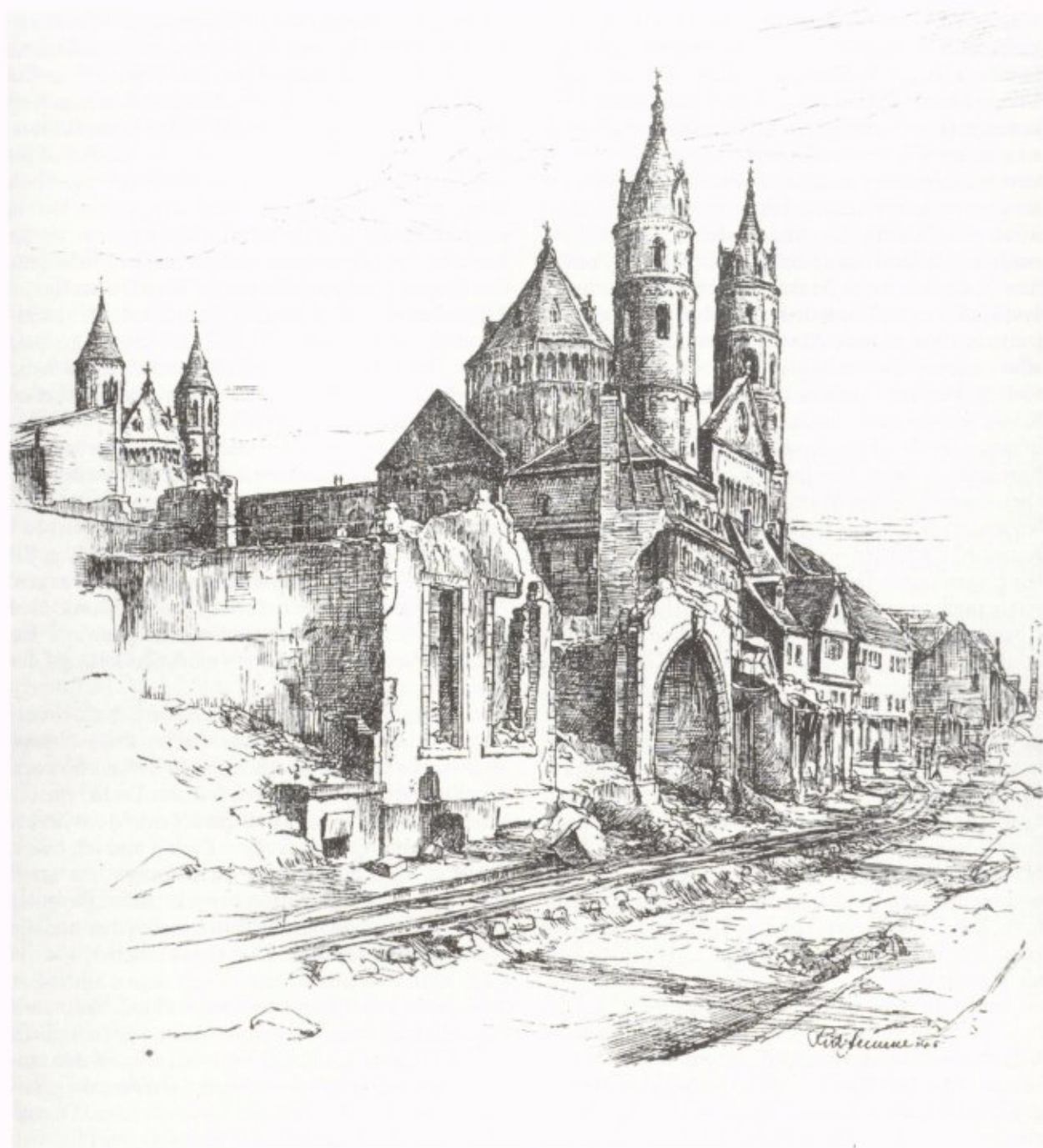
Blick aus der Valckenbergstraße mit den Schienen der „Trümmerbahn“ für die Entrümmung der Innenstadt über die erhalten gebliebene Adler-Apothek zum Dom, gezeichnet Sommer 1945 von Richard Stumm, gedruckt Januar 1946 als Beilage zum Wiederaufbauplan.
