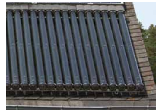
Bei geringer Kollektorfläche können leistungsfähige Röhrenkollektoren eingesetzt werden.
