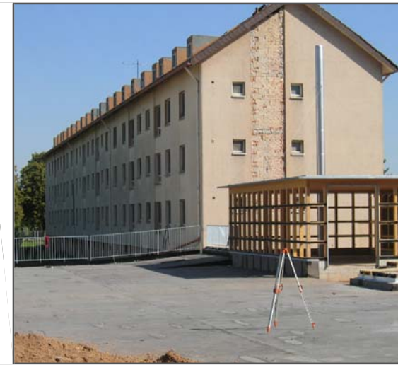
Geschosswohnungsba Carl-Schurz-Straße vor der Modernisierung
