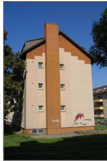
Geschosswohnungsba Carl-Schurz-Straße vor der Modernisierung
