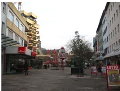
Am Römischen Kaiser vor Baumaßnahme
