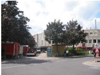
Platz vor Baumaßnahme
